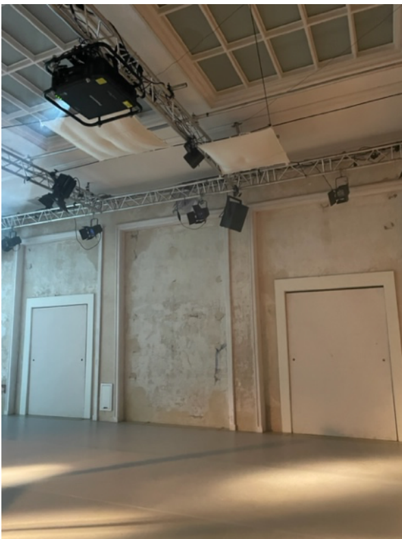
Aufhängung der Schneetücher und der Seilkonstruktion zum Auslösen / Schütteln
